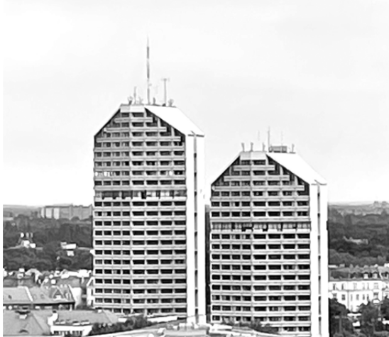
Rys.6. System antenowy na dachu akademika – Wrocław
