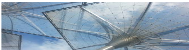
Rys. 3. Przykład zastosowania szkła akrylowego jako osłony przeciwdeszczowej.
