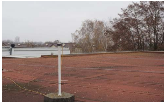
Rys. 2. Czujnik promieniowania słonecznego LB-900/LB-901 stacji meteorologicznej LB-719 zamontowanej na dachu Politechniki Warszawskiej Filii w Płocku
