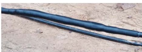
Rys.4. Mufa kablowa typu 24-EPJ-1/120-240 po montażu w terenie
