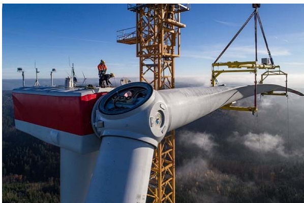
Rys.3. Montaż łopatek turbiny wiatrowej na wieży w Gaildorf, Foto: [A] (Holger Hesselthaler)
