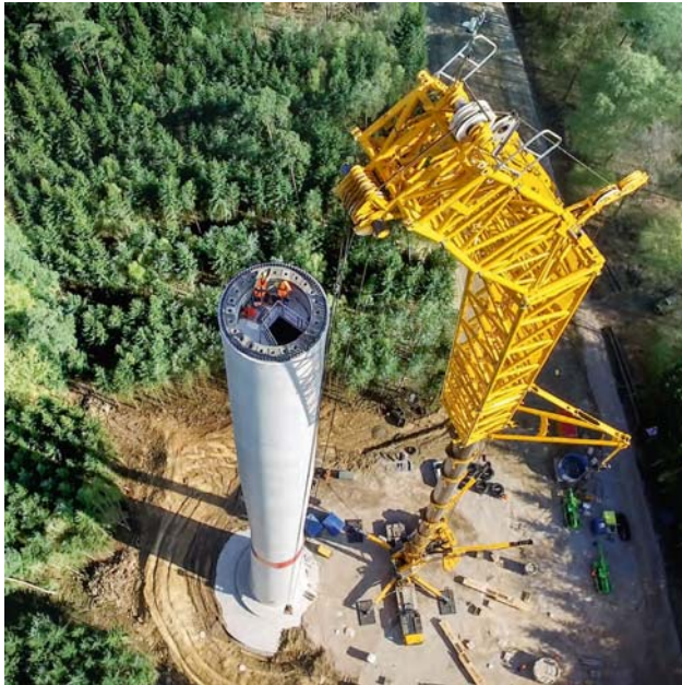
Rys. 6. Montaż wieży stalowej za pomocą dźwigu, Foto: [A]
