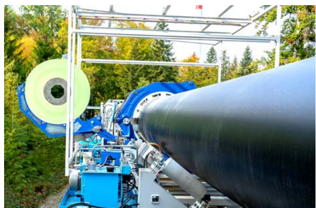
Rys.8. Montaż rurociągu Egelplast za pomocą maszyny PIPECrawler, Foto: [A]
