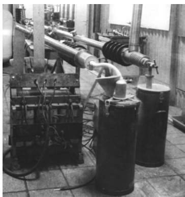
Rys.5. Prototyp kabla nadprzewodzącego. Zdjęcie udostępnione przez Bolesława Mazurka.
