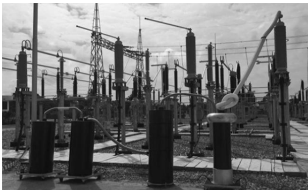
Rys.2. Przykład badania linii kablowej w miejscu jej zainstalowania z wykorzystaniem sinusoidalnego tłumionego napięcia przemiennego. Linia kablowa 161 kV, o długości 6,0 km z izolacją XLPE, system probierczy napięcia tłumionego DAC HV300 jest podłączony do jednej z faz badanej linii
