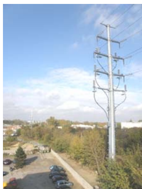
Rys.2. Słupy kablowe 110 kV – różne rozwiązania techniczne: a - słup kratownicowy, b - słup rurowy
