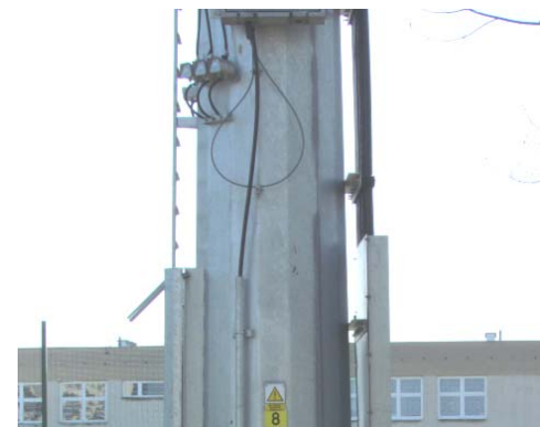
Rys.3. Sposób montażu liczników zadziałów na słupie kablowym: a) w wykonaniu kratownicowym, b) w wykonaniu rurowym.
