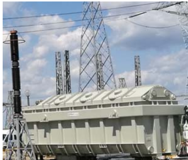
Rys. 8. Kadź autotransformatora po przetransportowaniu na miejsce instalacji
