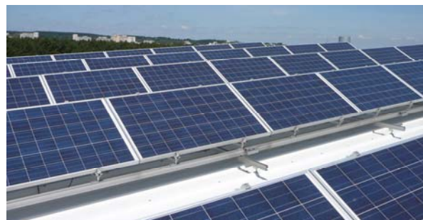
Rys. 3. Przykład BAPV: stacjonarna dachowa konstrukcja nośna na wytwórni Frosta w Bydgoszczy, foto: G. Frydrychowicz-Jastrzębska
