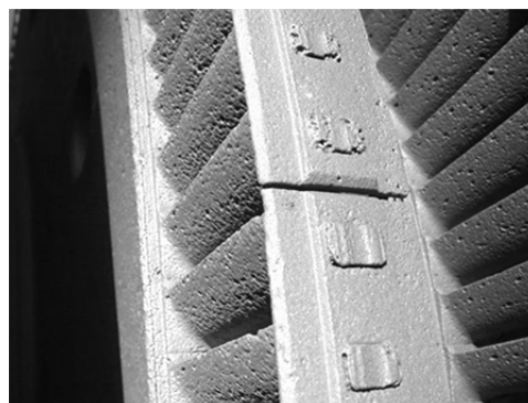
Rys.2. Erozja powierzchni łopatek turbiny.
