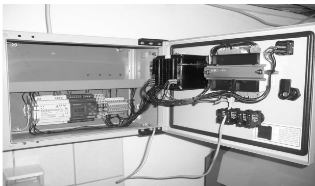
Rys. 2. Rozdzielnica z sterownikiem Logo
