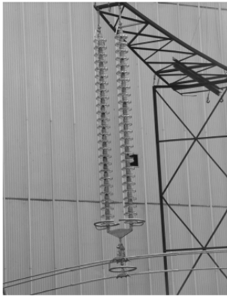
Rys. 1. Łańcuch ŁP2 – 400 kV wraz z imitacją głowicy słupa oraz wiązki przewodowej w polu probierczym
