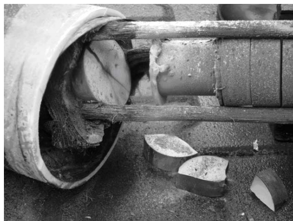
Rys. 5. Uszkodzone warystory po rozszczelnieniu, przebieciu i pożarze ogranicznika przepięć NN
