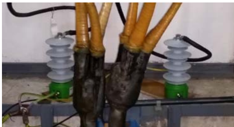
Rys.4. Instalacja sprzęgaczy pojemnościowych do transmisji metodą różnicową
