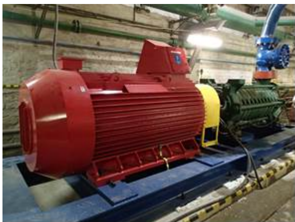
Rys. 7. Prototypowy silnik synchroniczny z magnesami trwałymi napędzający pompę
