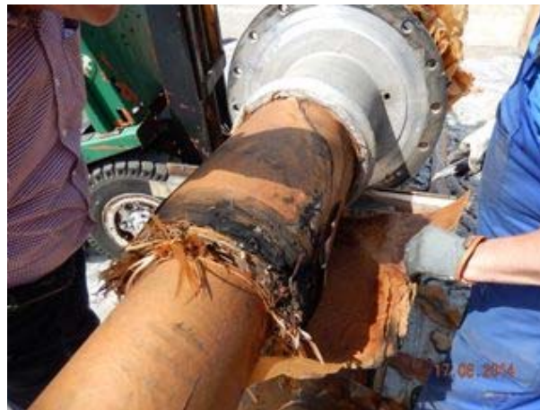
Rys.3. Demontaż przepustu i widoczny kanał przewodzący na papierowym rdzeniu kondensatorowym
