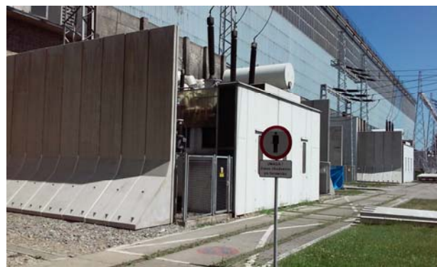
Rys.7. Nowe ściany oddzielenia przeciwpożarowego
