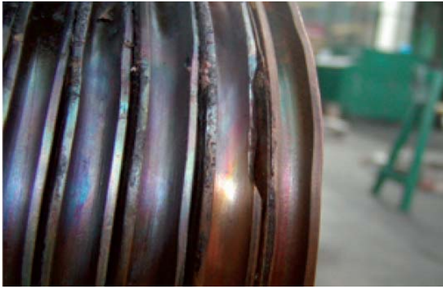
Rys. 5. Zdjęcie czoł uzwojenia wzbudzenia remontowanego generatora GTHW 360
